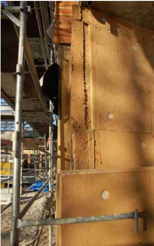
Isolation extérieure en fibres de bois © sa
